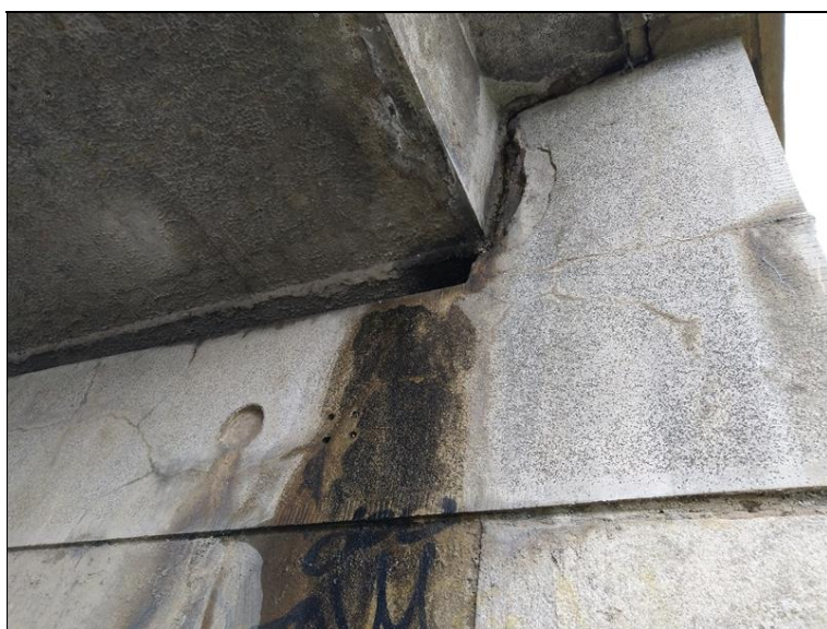
Stopy po zatékání na OP1.jpg
