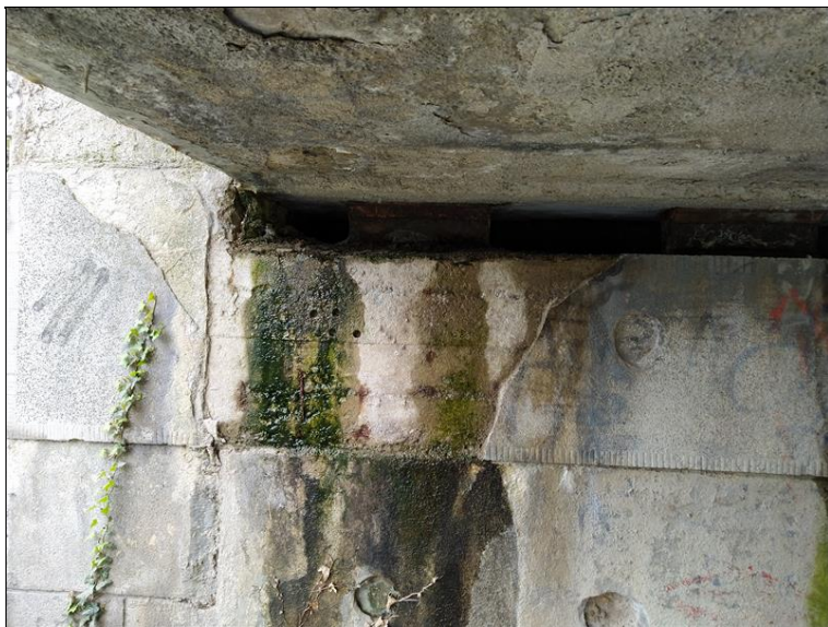
Stopy po zatékání na první opěře.jpg
