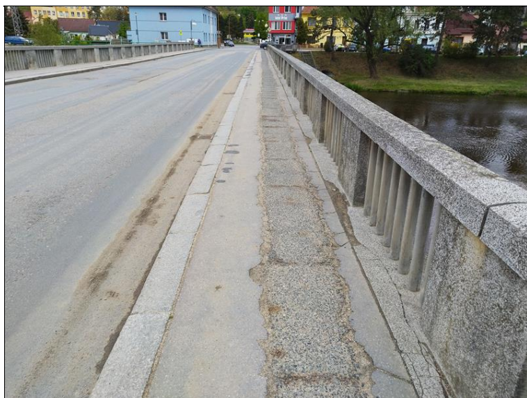
Trhliny v asfaltu na choníku.jpg
