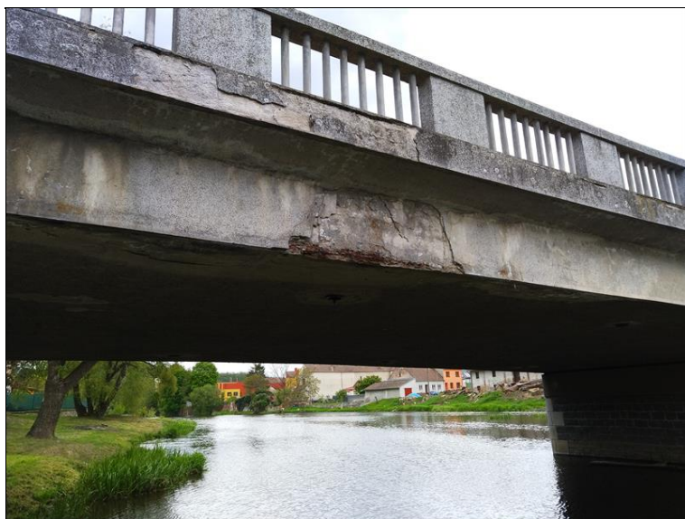
Koroze nosné výztuže na pravé straně mostu.jpg
