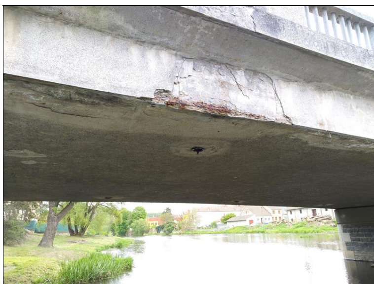
Odprýsknutá hrana NK, stopy po zatékání.jpg
