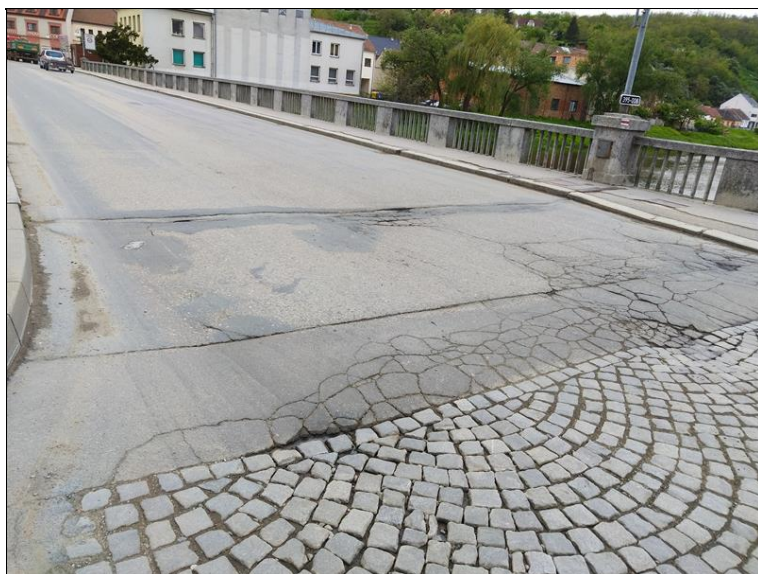
Trhliny ve vozovce v místě dilatace mostu.jpg
