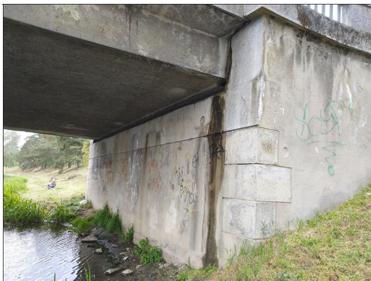
Stopy po zatékání na křídle.jpg
